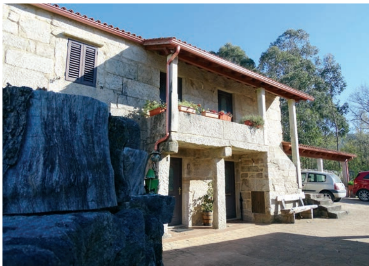
Casa tradicional con escaleira exterior de dous tramos e corredor no lugar do Carbón
