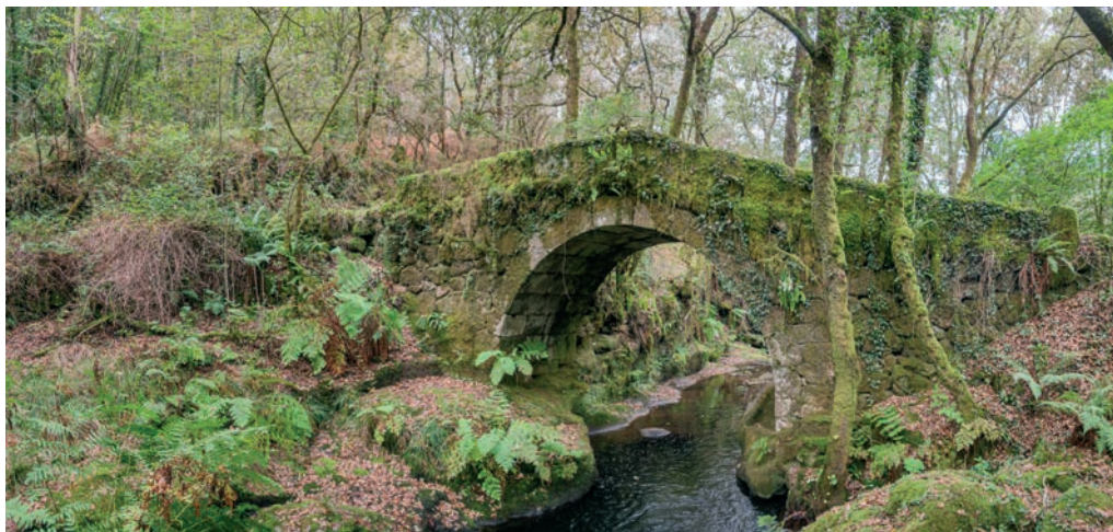
Un dos alzados da ponte. Foto Julio Eiroa.
