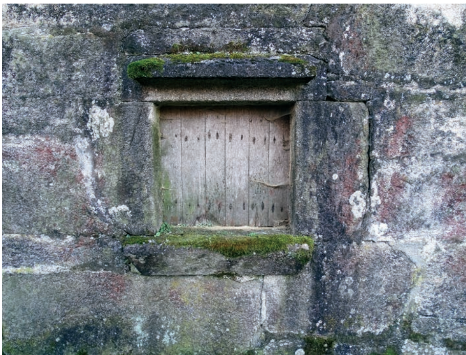
Xanela-mostrador con peitoril e tornachuvias na planta baixa dunha casa do Galeón
